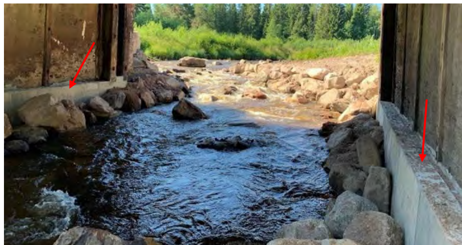
Figur 18. Exempelbild från Limån där betongförstärkning gjutits på vid befintliga utskovsväggar efter utrivning av luckor och skibord, se röda pilar.
