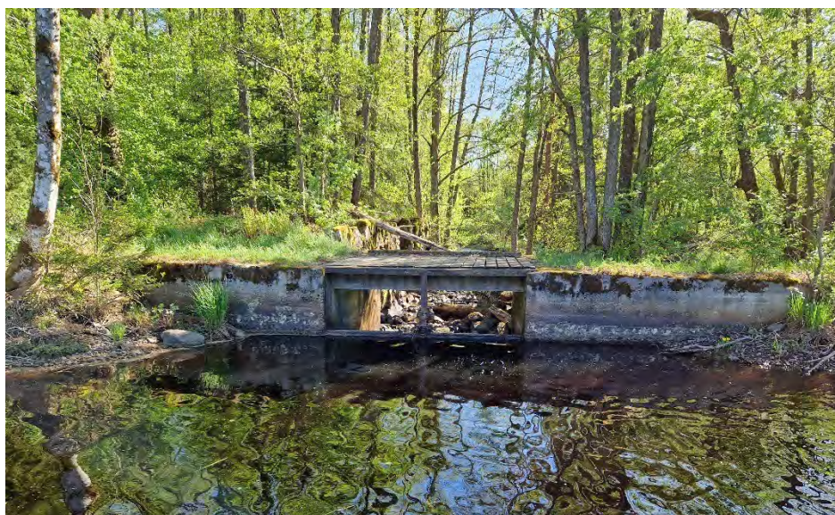
Figur 5. Nedströmsvy mot vänstra sättutskovet som mynnar i kvarnrännan.
