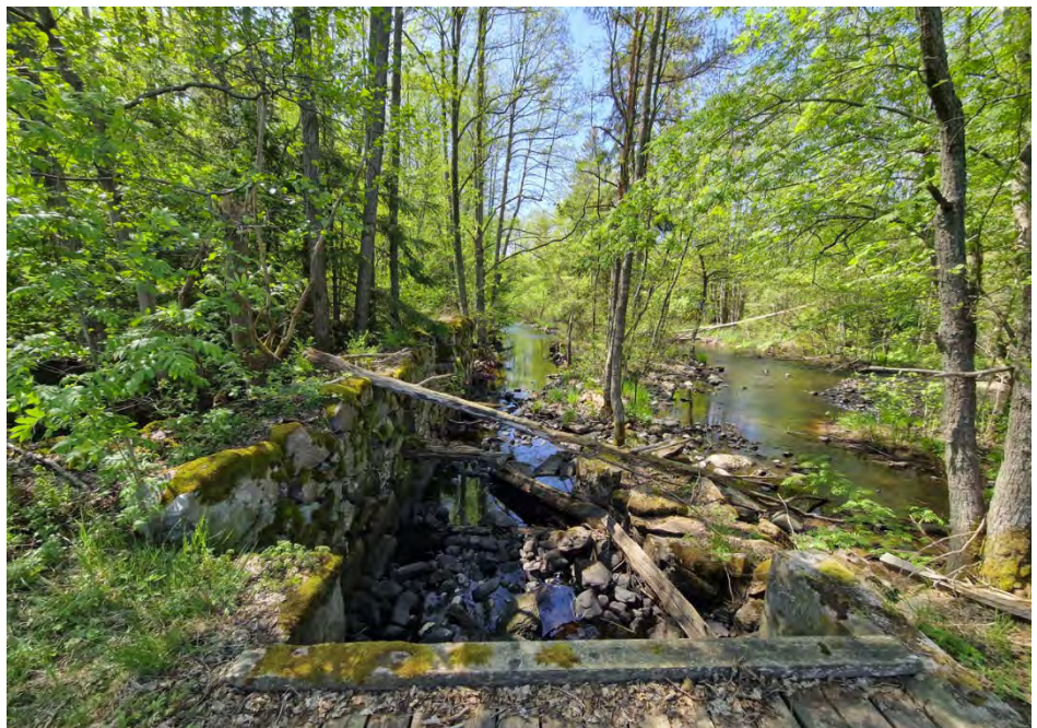
Figur 10. Nedströmsvy mot kvarnrännan och naturfåran. Rensvallen sträcker sig ca 50 m nedströms dammvallen. Vid inmätningstillfället utgjorde kvarnrännans flöde av läckvatten från sättutskovet.
