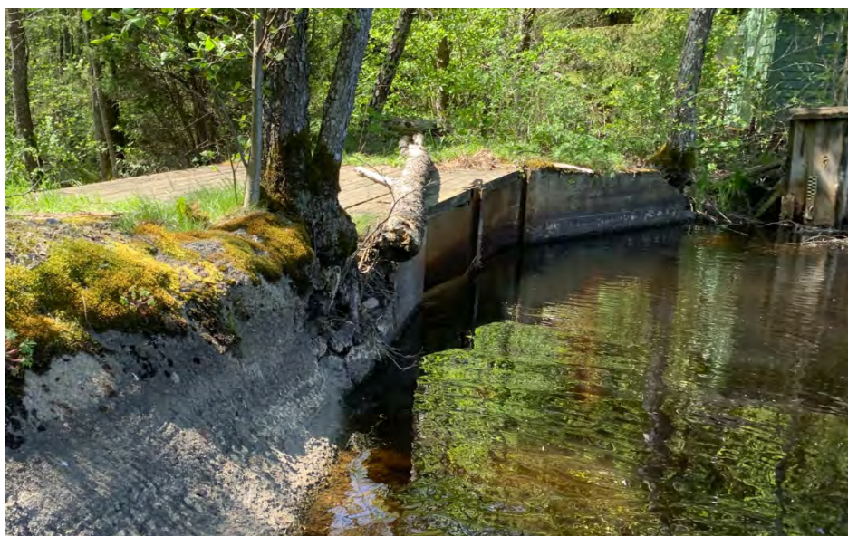
Figur 7. Nedströmsvy mot högra sättutskovet. T.v. i bild syns en spar-tansk förstärkning av dammvallen som utgörs av cement som hållts över dammvallens mittsektion närmst höger sättutskov.
