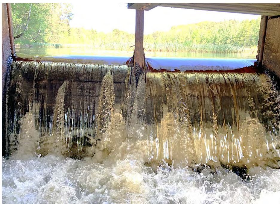
Figur 16. Sättar plockas succesivt bort vid avsänkning. Uppströmsvy mot höger utskov.
