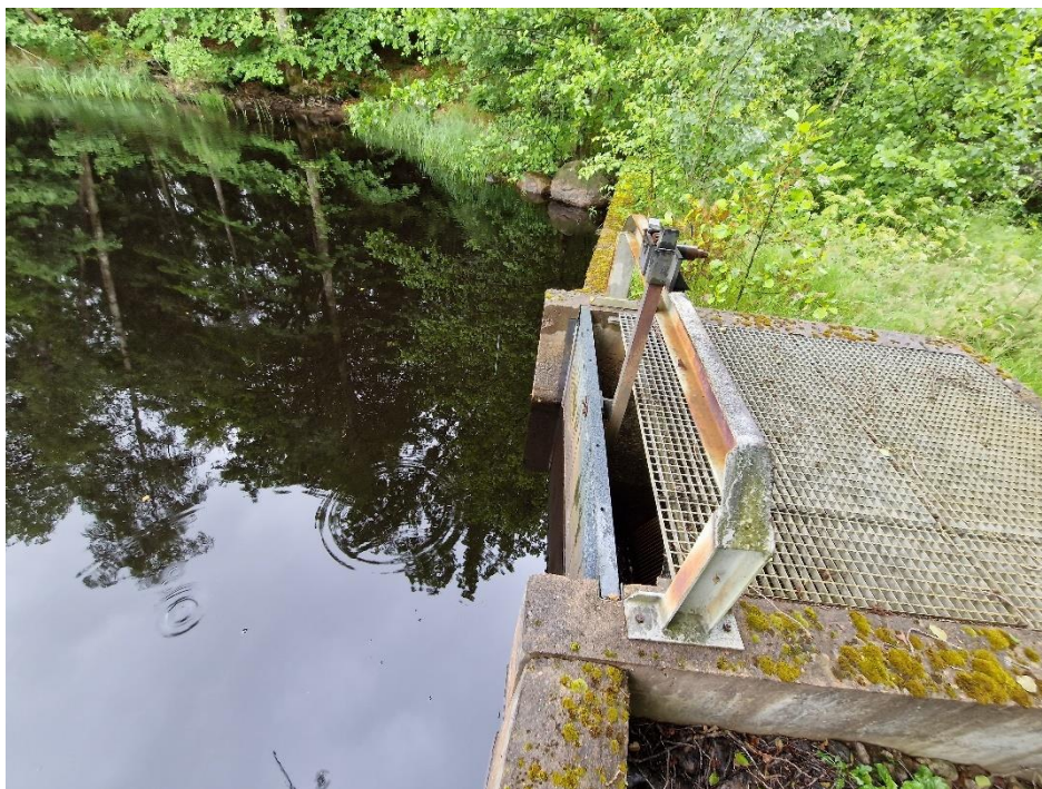
Figur 7. Kraftverksintaget till vänster om utskovet.
