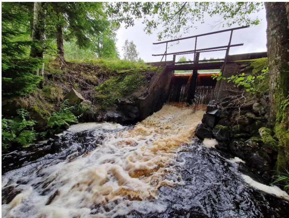
Figur 6. Utskovet i dammbyggnaden.
