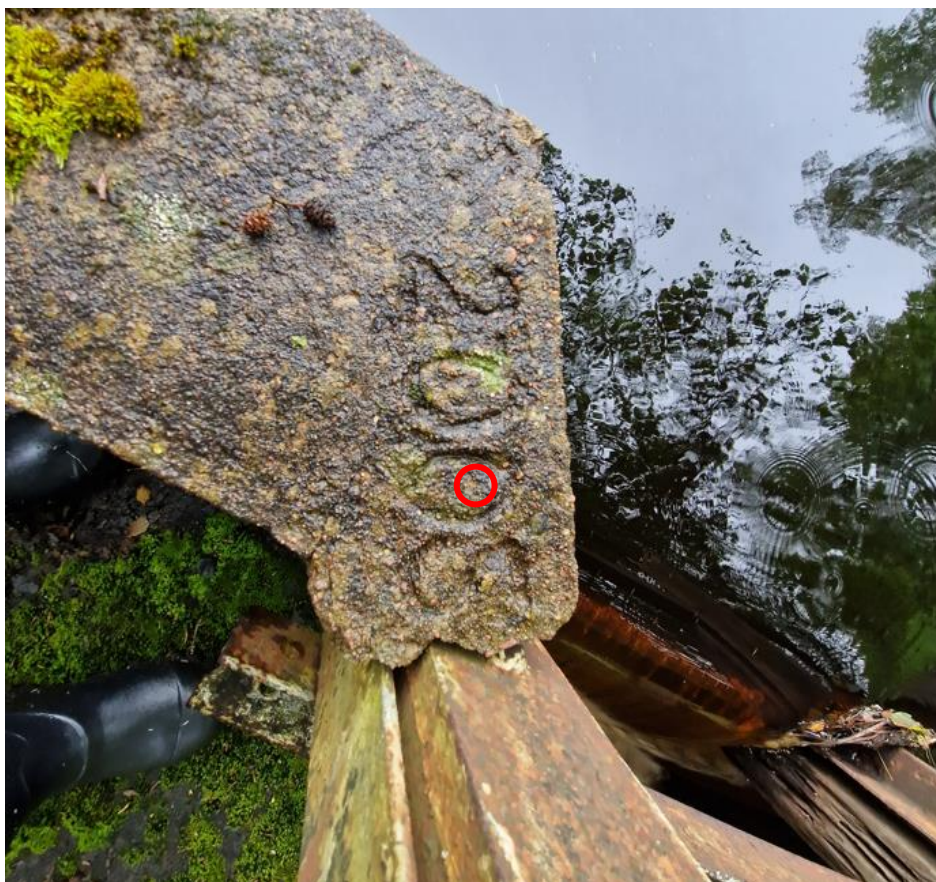
Figur 2. Fixpunkt för upprättande av lokalt höjdsystem med höjden +10,00.
