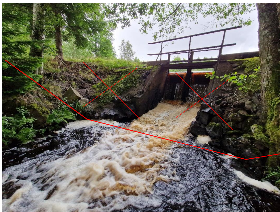
Figur 10. Utskov och betongdamm rivs ut och åfåran återställs.
