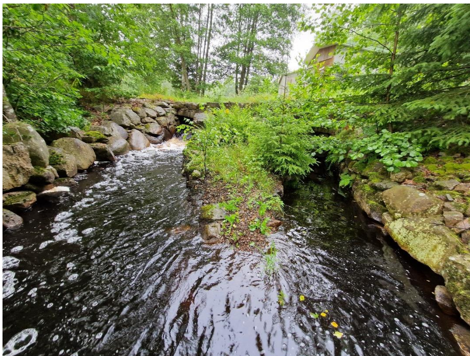
Figur 9. Sammanflödet mellan naturfåran (vänster) och utloppskanalen höger.
