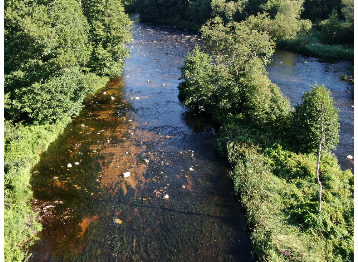
Figur 2. Blockrensat område efter åtgärd (2022).
