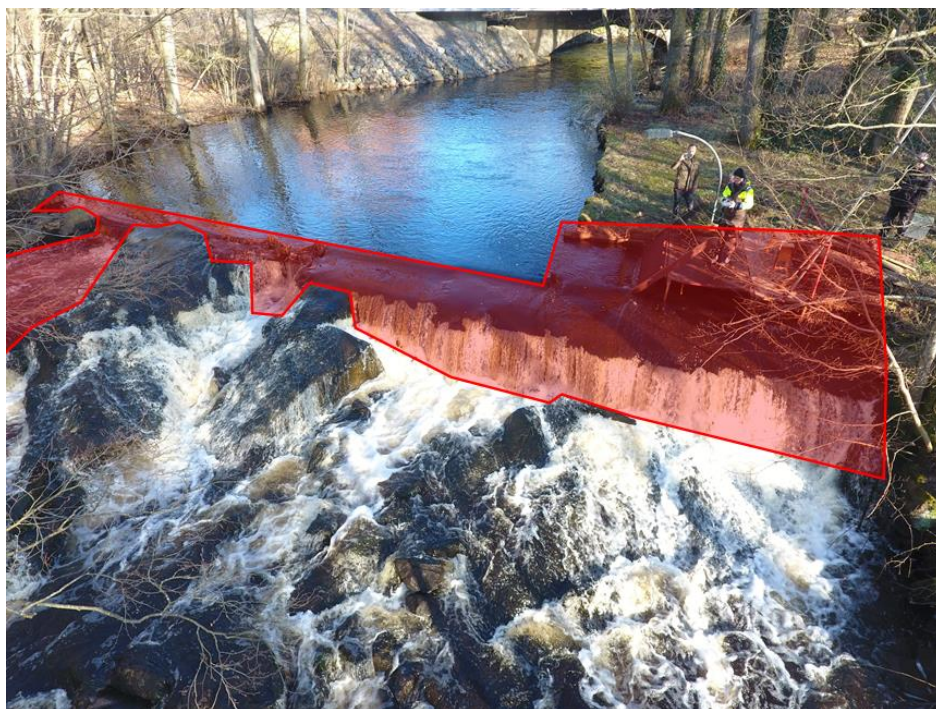
Figur 8. Rödmarkerade delar av dammanläggningen rivs.
