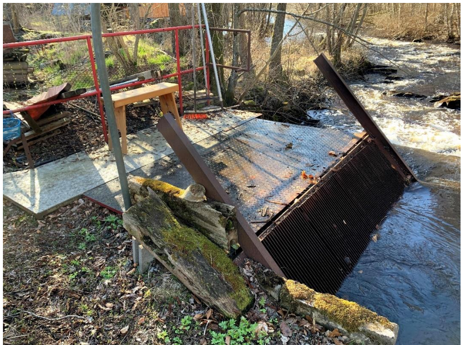
Figur 4. Galler framför intag med 45 graders lutning och 20 mm spaltvidd.
