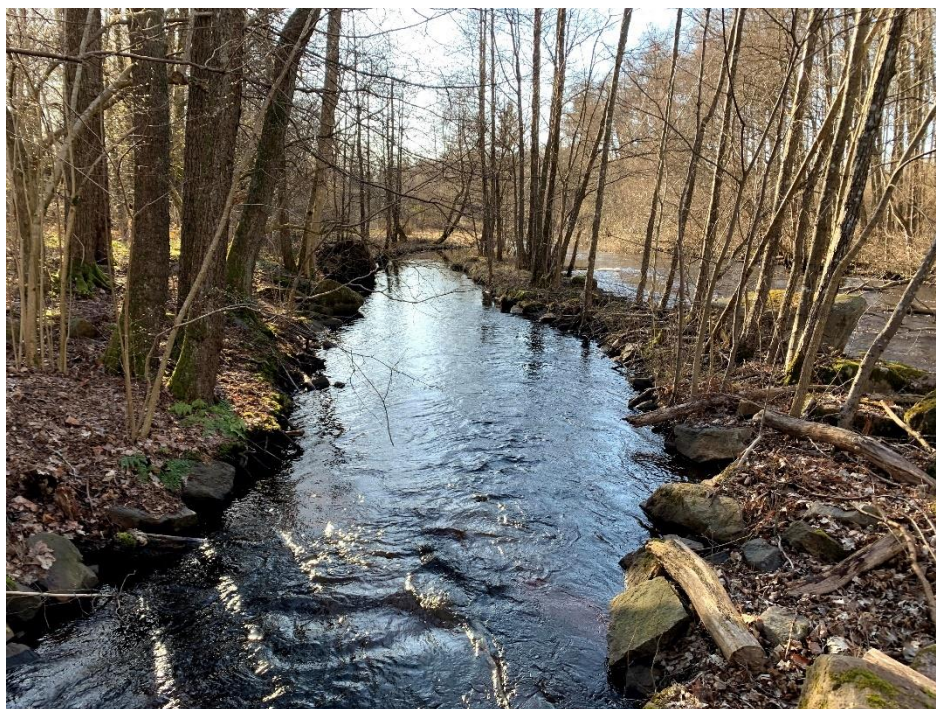
Figur 5. Nedströmsvy över Röamölla Nedres utloppskanal. Rössjöholmsåns huvudfåra syns t.h. i bild.
