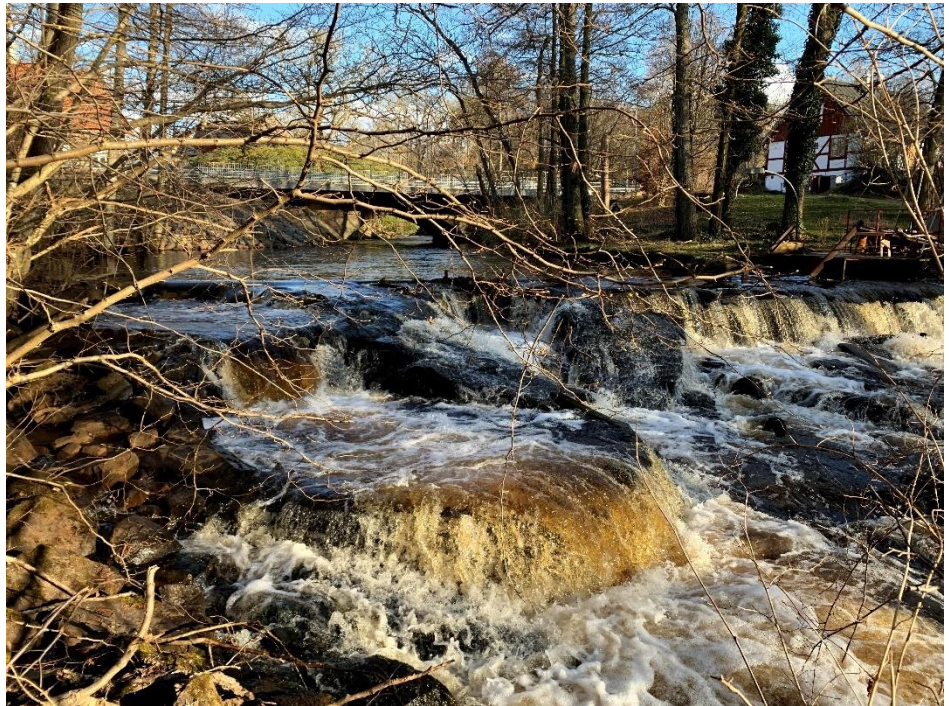
Figur 3. Fiskvägen i form av en bassängtrappa vid norra stranden.
