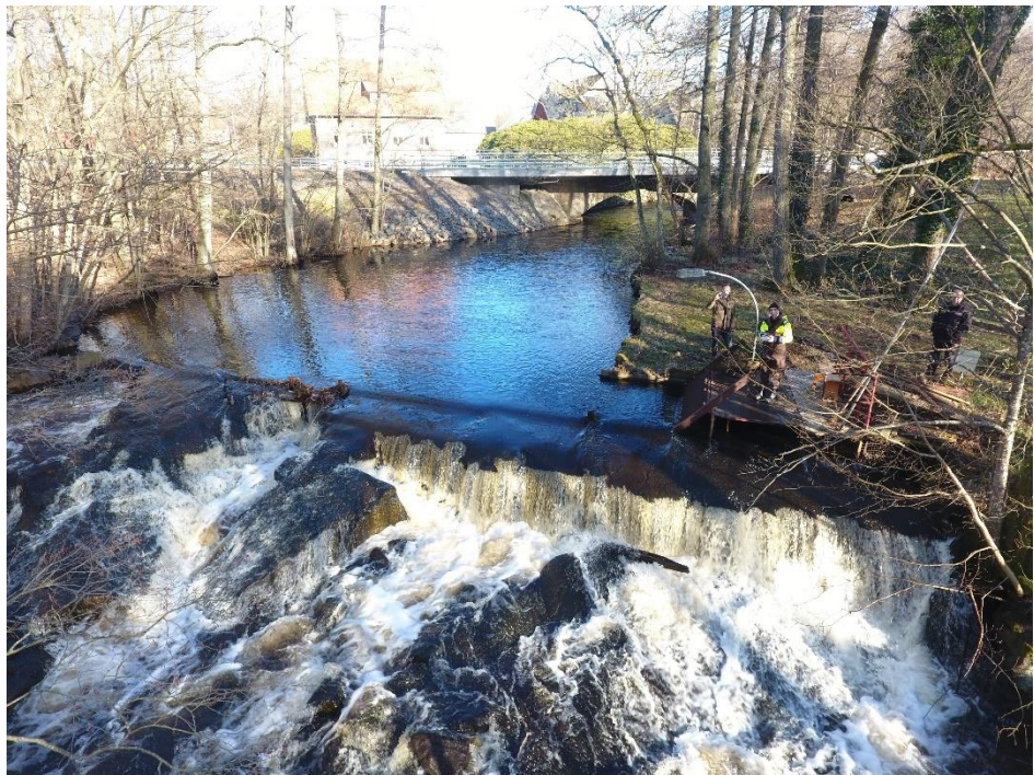
Figur 2. Uppströmsvy över dammanläggningen vid Röamölla nedre.
